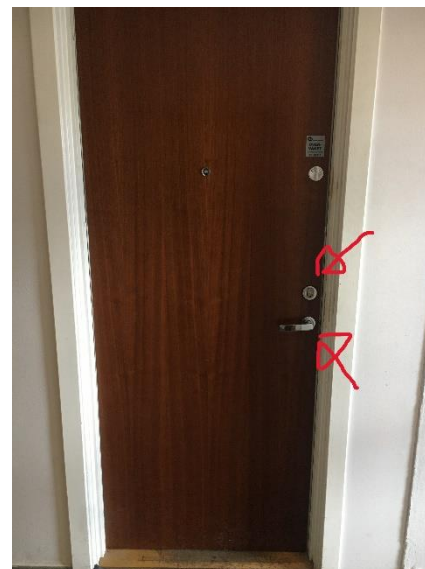
Plassering av brekkjern
